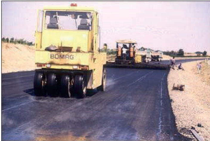
Fig. 67 Modernizimi i rrugëve
