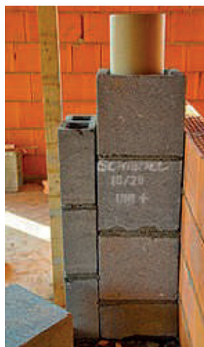
Fig. 117 Kanal ventilimi prej elementeve të parafabrikuara
