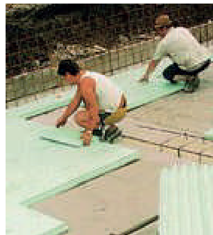
Fig. 70 Mbështjellje e fasadave dhe dyshemeve me stirodur-c
