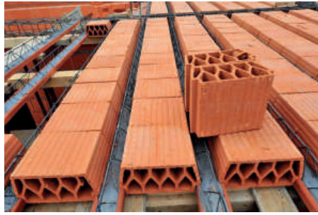
Fig. 34 Bllok qeramik "mont" për konstruktion ndërmjet kateve
