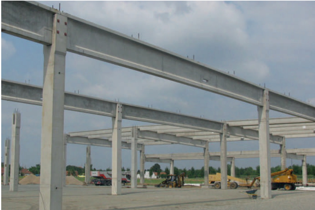
Fig. 86 Kornizë e armuar betoni
