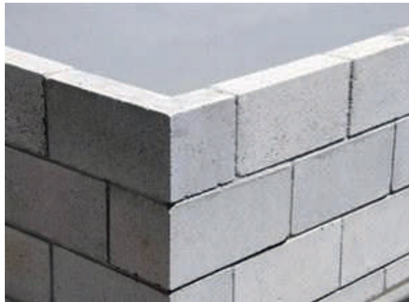
Fig. 107 Mur nga blloqe betoni
