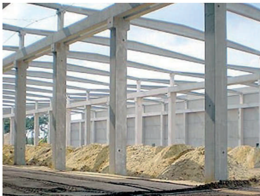
Fig. 85 Kornizë e armuar betoni
