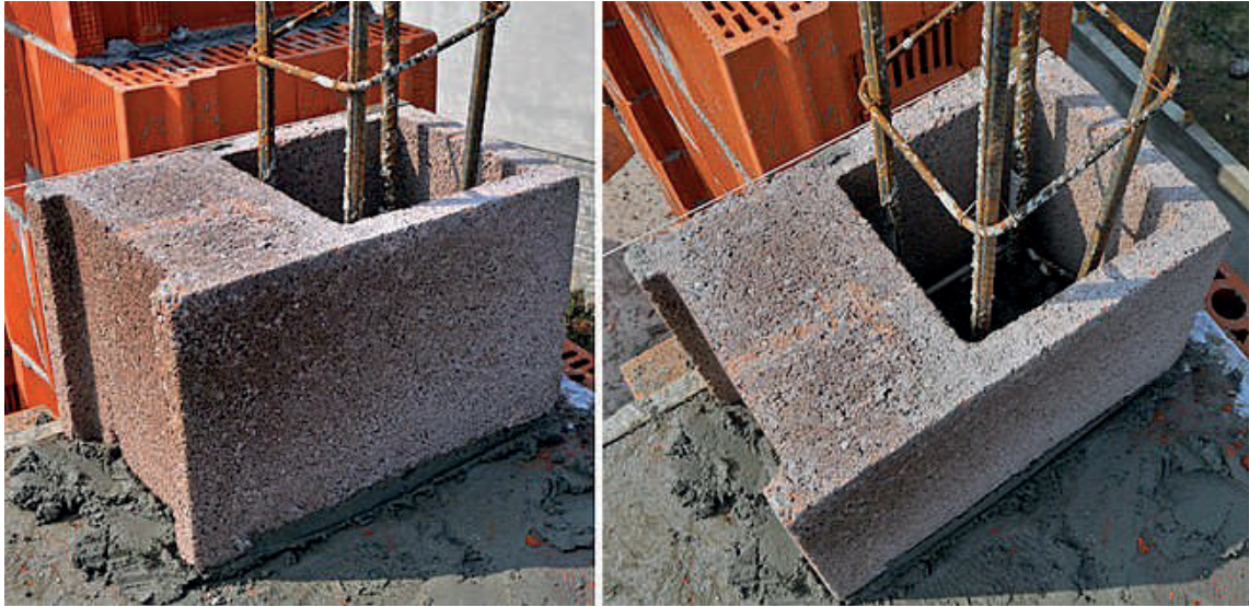
Fig. 115 Realizimi i shtyllës me beton-arme me blloqe të rifabikuara në vend të kallëpit klasik
