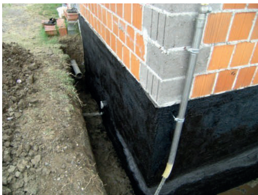
Fig. 101 Hidroizolimi vertikal i murit me shirita bitumeni
