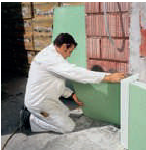
Fig. 70 Mbështjellje e fasadave dhe dyshemeve me stirodur-c
