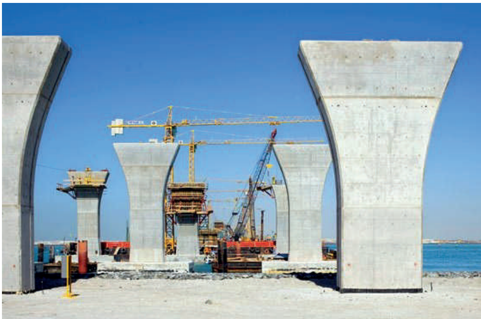
Fig. 114 Shtylla me beton-arme
