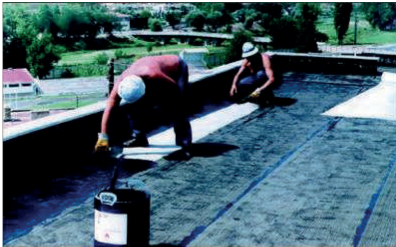
Fig. 69 Hidroizolimi i çatisë së rrafshët
