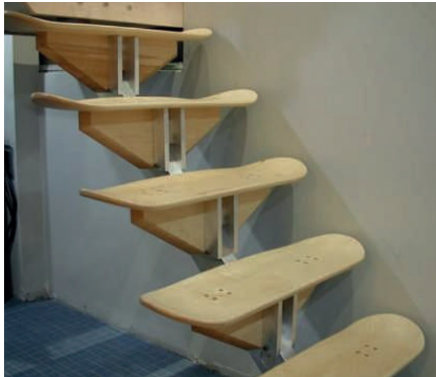
Fig. 136 Shkallare të mbështetura në trarë të pjerrët metalik
