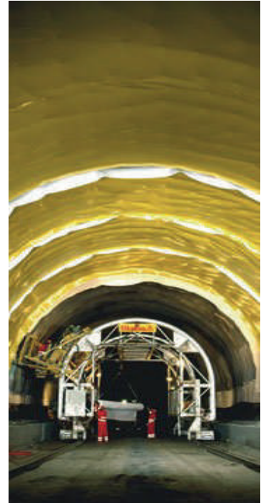
Fig. 68 Hidroizolimi i tunelit
