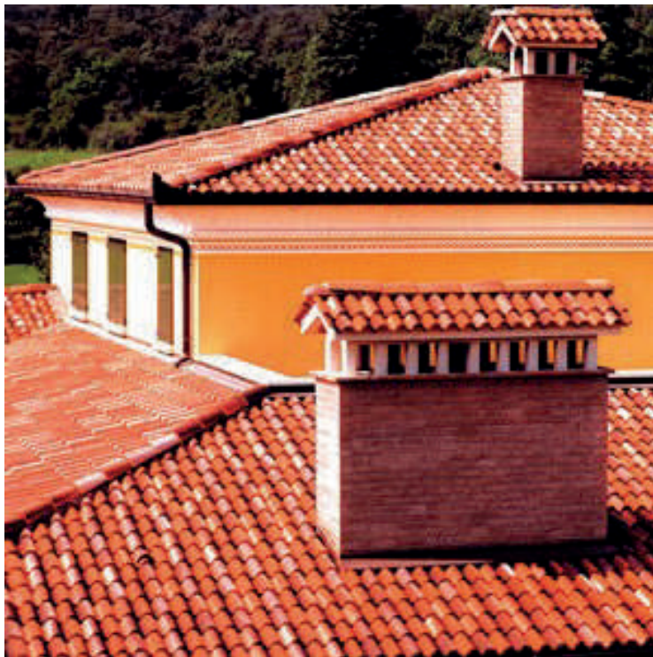
Fig. 145 Mbulesë çatie me tjegull të petëzuar
