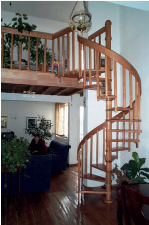
Fig. 135 Shkallë spirale në shtyllë të mesme
